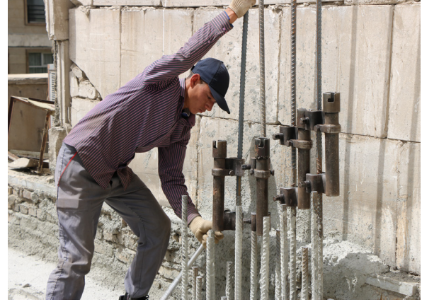
اجرای جوش سر به سر میلگرد میدان هروی کارفرما: مهندس باقری زمان: ۱۴۰۱-۱۴۰۰
