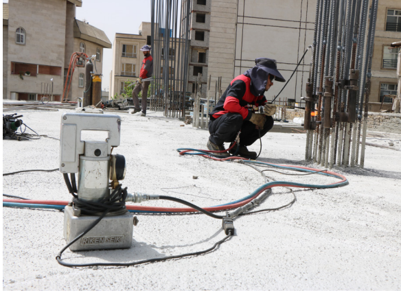
اجرای جوش سر به سر میلگرد میدان هروی کارفرما: مهندس باقری زمان: ۱۴۰۱-۱۴۰۰
